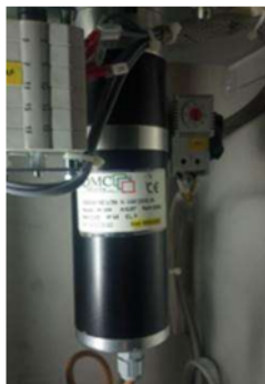
Figura 1 - Motor Chave Seccionadora 11/22/V2 avariado
